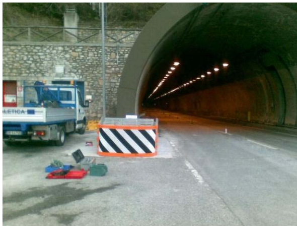
Attenuatore d'urto posto all'imbocco della carreggiata di discesa
