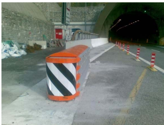
Attenuatore d'urto posto all'imbocco della carreggiata di discesa
